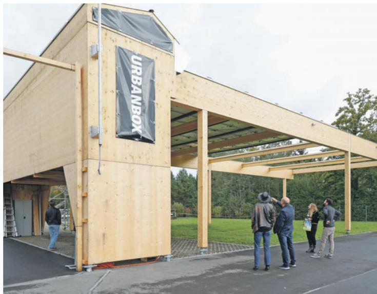
Die Urbanbox ist mit einem Faltdach ausgerüstet. Bei schlechtem Wetter werden die Solarmodulträger automatisch eingefahren und zeitgleich gereinigt.
